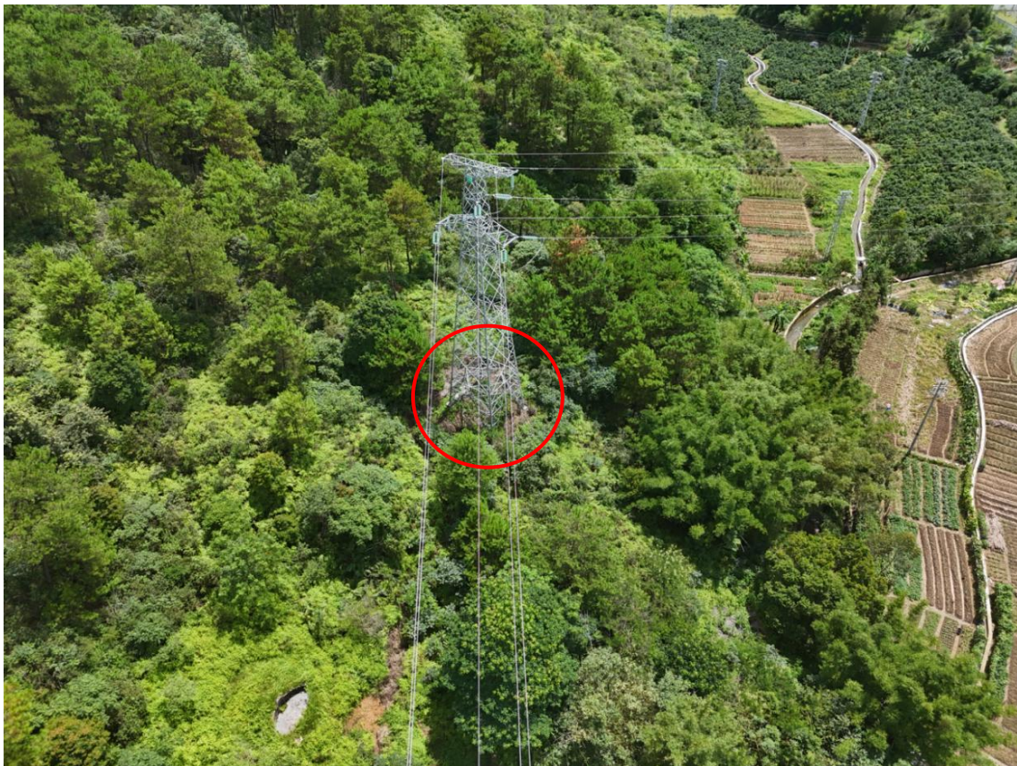
35kV 蒙城线 T 接田蒙 I 线及升压改造为 110kV 线路（新建 JD3 塔）塔基恢复情况
