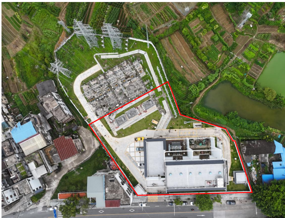
110kV 城北变电站改造区恢复情况
