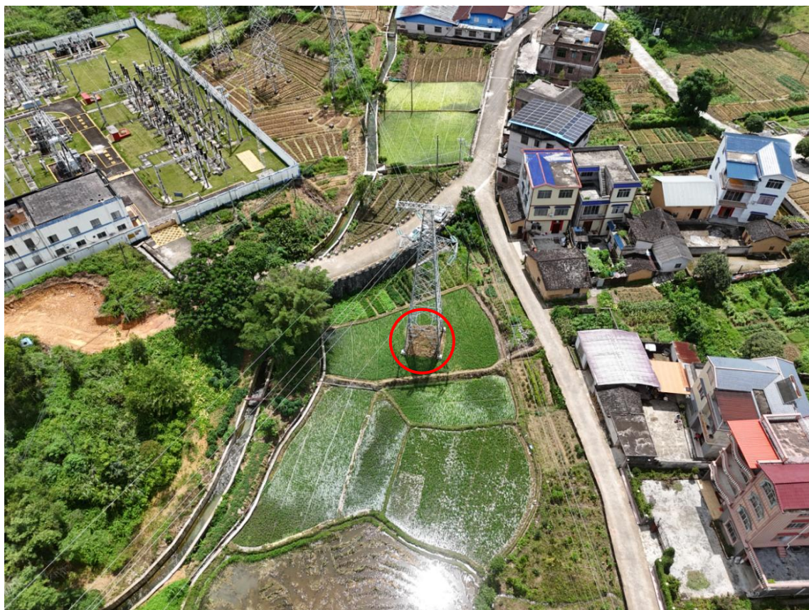
35kV 蒙城线 T 接田蒙 I 线及升压改造为 110kV 线路（新建 JD2 塔）塔基恢复情况
