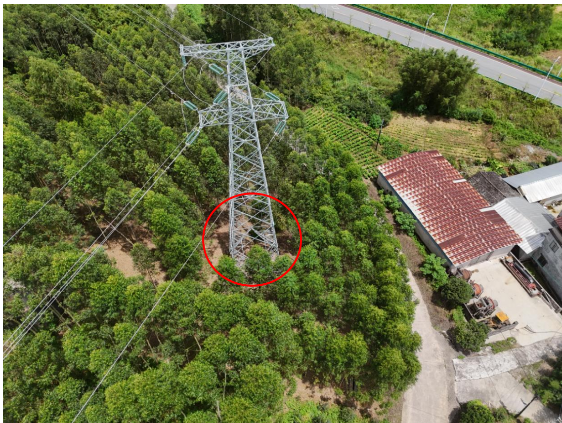
35kV 鳌峰~县城线路（新建JB4塔）塔基恢复情况
