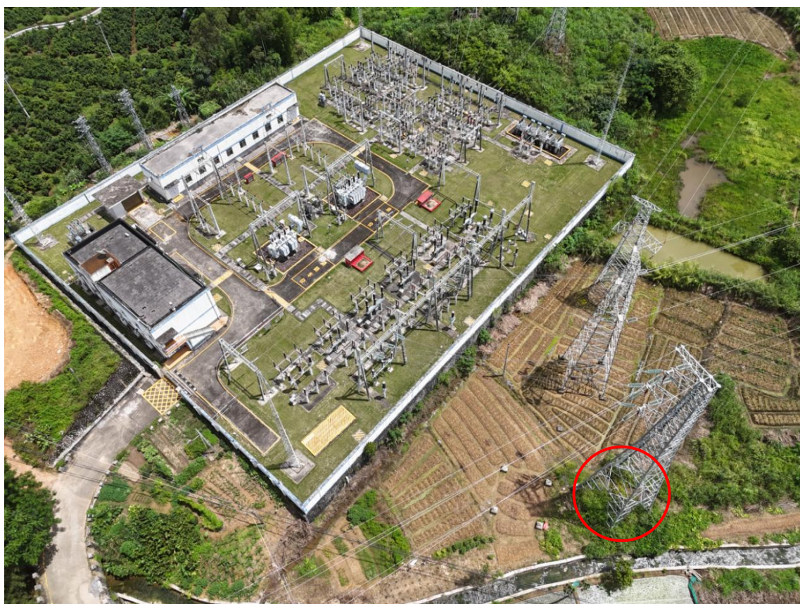
35kV 蒙城线 T 接田蒙 I 线及升压改造为 110kV 线路（新建 JD1 塔）塔基恢复情况
