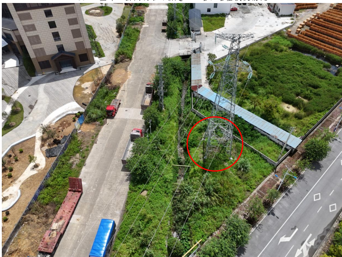
35kV 蒙城线 T 接田蒙 I 线及升压改造为 110kV 线路（新建 JD4 塔）塔基恢复情况
