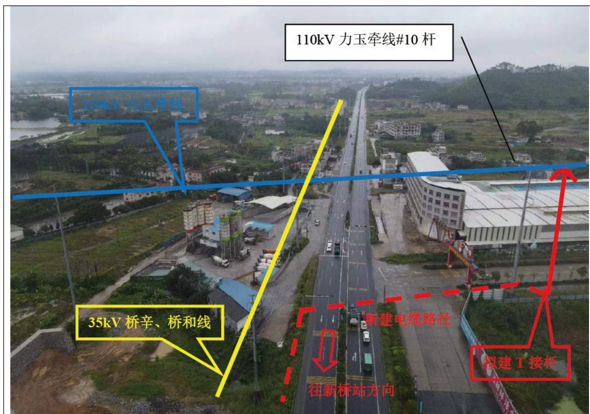
线路 T 接点现状 (2026 年 5 月)
